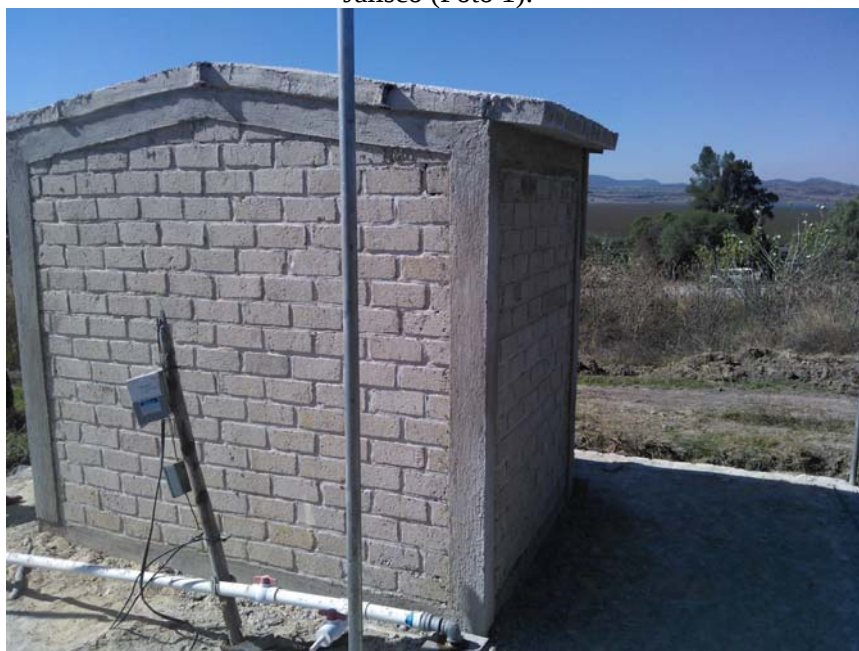
Imagen 41. Pozo de agua construido en la localidad de San Pedro Valencia, Municipio de Acatlán, Jalisco (Foto 1).
