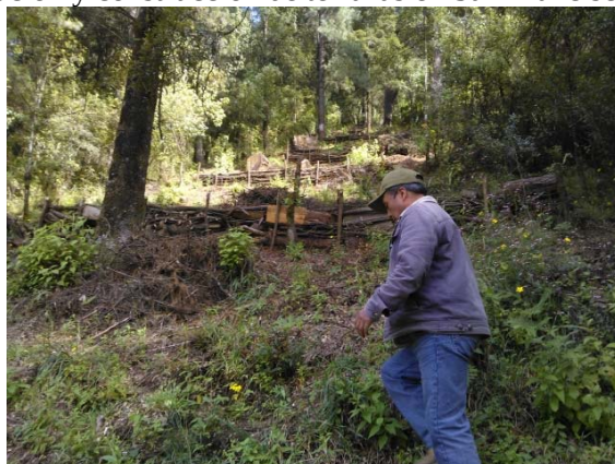
Imagen 20. Reforestación y construcción de terrazas en San Francisco Oxtotilpan (Foto 4).
