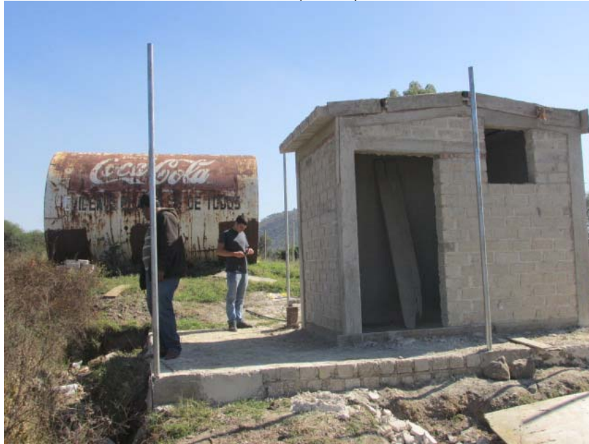
Imagen 42. Pozo de agua construido en la localidad de San Pedro Valencia, Municipio de Acatlán, Jalisco (Foto 2).
